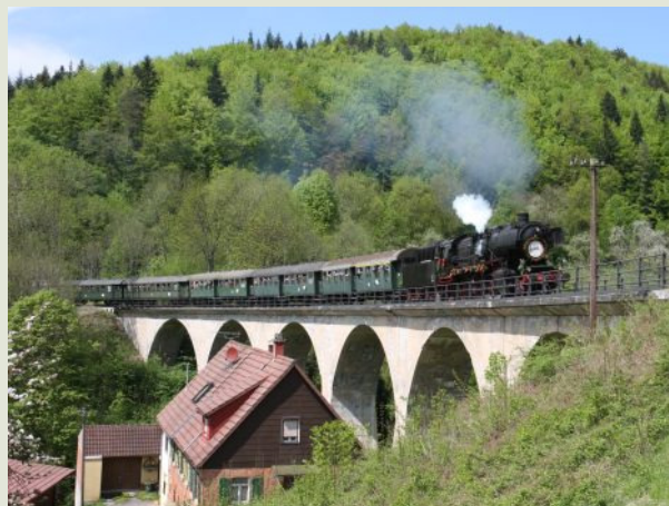
Dampfzug auf Strümpfelbach-Viadukt. Aufnahme: R.Vogler
